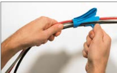
Kabelbündel seitlich in das Aufziehwerkzeug legen.
