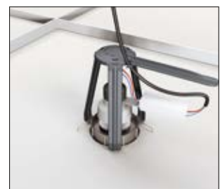
4. Netzteil anschließen und Leitung am Kabelhalter befestigen.
