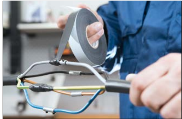
HelaTape Power 810 Primäisolierung bis zu 69Kv
