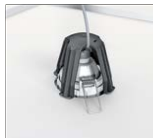
3. Beginnen Sie mit der sicheren Installation des Einbaustrahlers.
